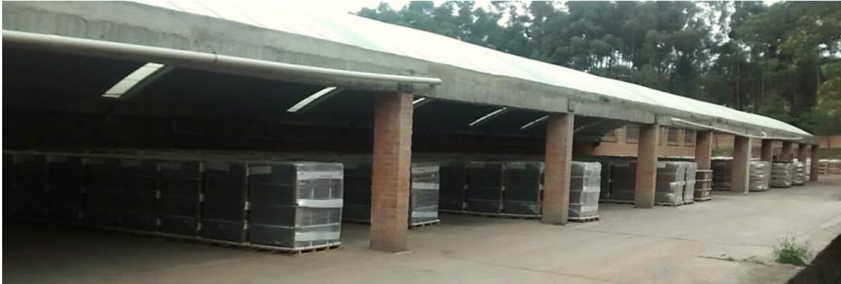
Ilustración 13 Almacenamiento de las estibas.
