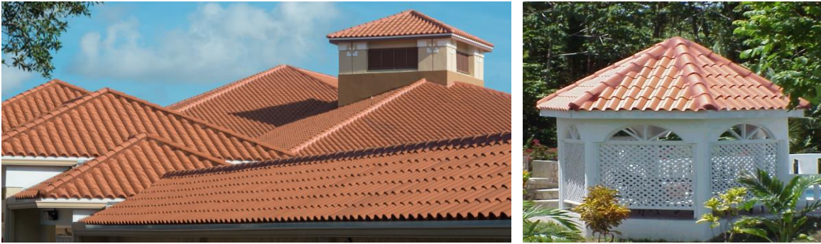
Ilustración 34 Teja "S" Instalada.
