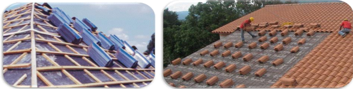
Ilustración 7 Instalación mediante clavos o tornillos del tejado.
