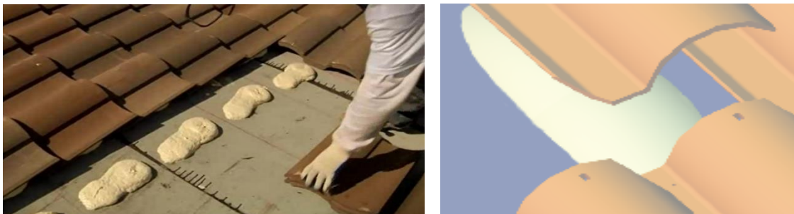
Ilustración 8 Instalación con adherencia de epóxicos o mortero a estructura de cubierta.
