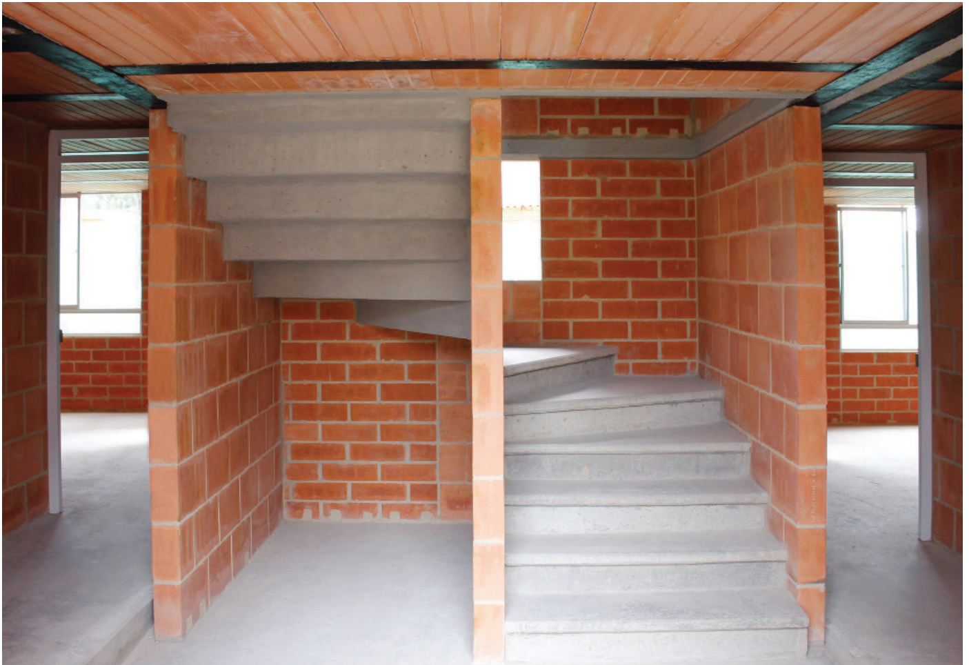
Sistema apoyado en muros estructurales
