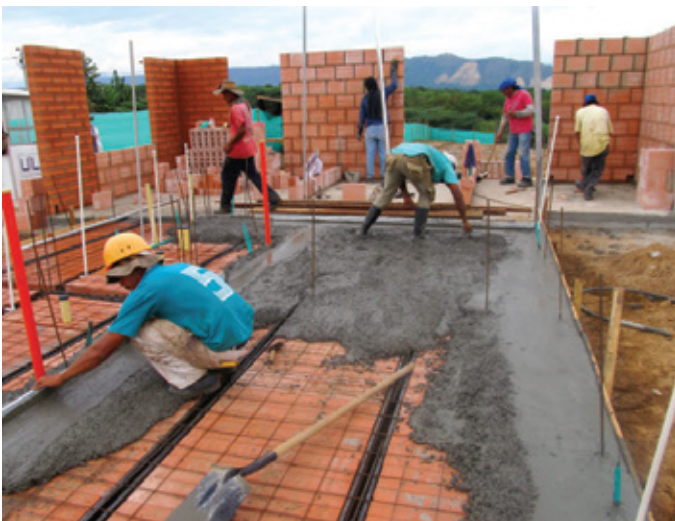
Colocación de concreto
